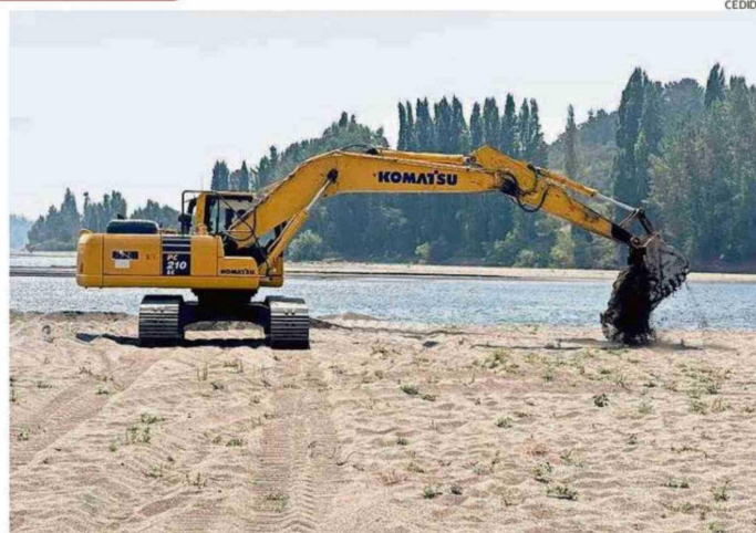
SE CONCLUYÓ CON SEIS POZOS PROFUNDOS.
