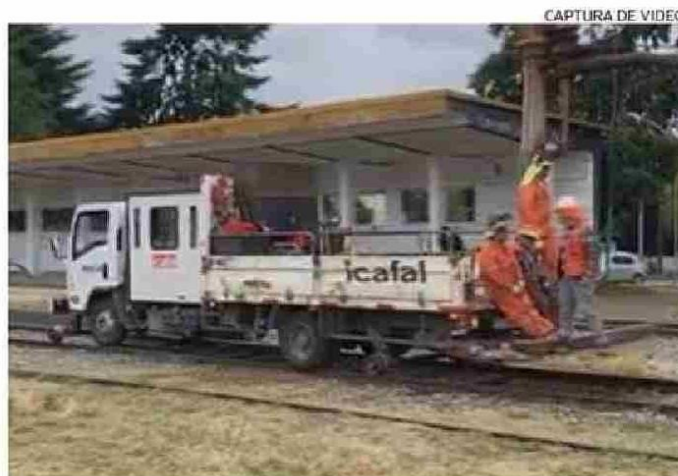
LOS TRABAJOS DE CONSERVACIÓN DE LA LÍNEA FERROVIARIA.
