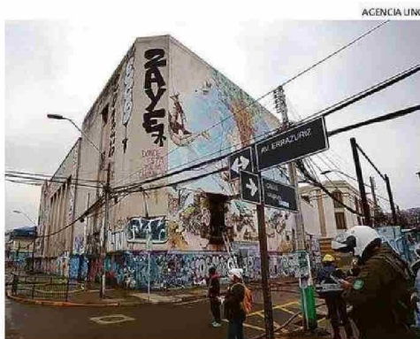
RECINTO NO FUE AFECTADO EN SU ESTRUCTURA GENERAL.
