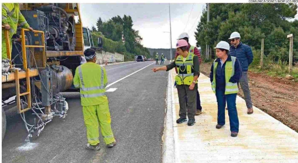
DURANTE SU VISITA INSPECTIVA A LAS OBRAS, LA SEREMI PERALTA EXPLICÓ QUE LOS TRABAJOS ACTUALES ESTÁN SUJETOS A LA CONDICIÓN CLIMÁTICA.
