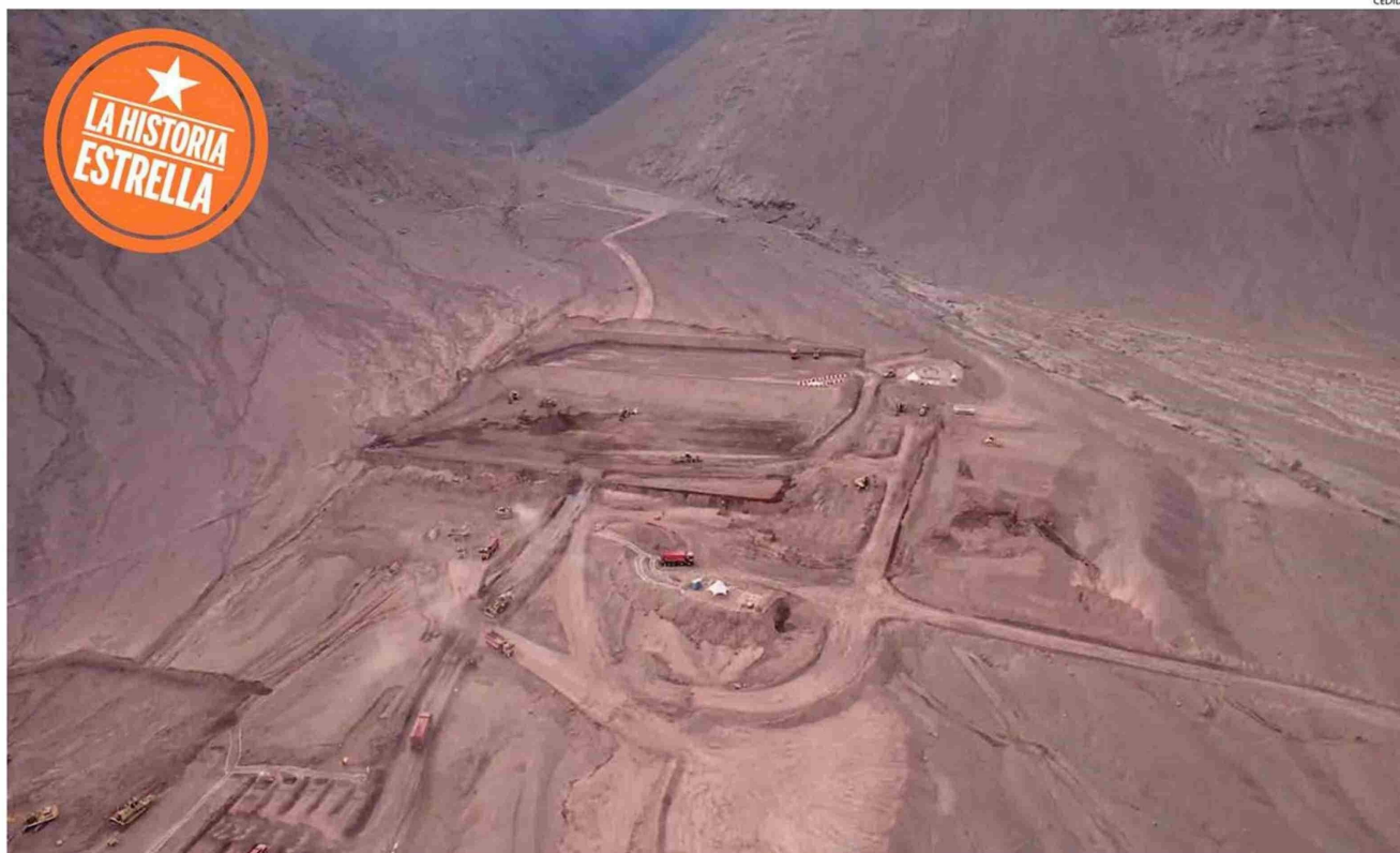
A 14 KILOMETROS AL SUR DE TOCOPILLA, EN EL SECTOR CALETA LA VIUDA, SE EMPLAZA ESTE PROYECTO PARA CONVERTIR A CODELCO EN UNA MINERÍA SOSTENIBLE CON EL MEDIO AMBIENTE.
