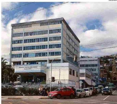
EL RECINTO REQUIERE URGENTEMENTE DE UNA AMPLIACIÓN.
