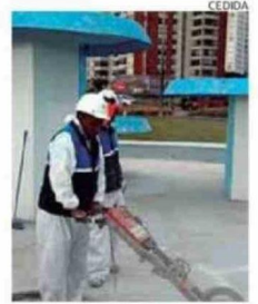
TRABAJOS EN PILETA SECTOR SUR.
