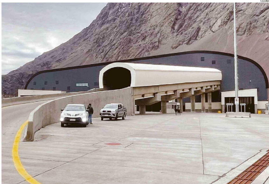
TRABAJOS COMENZARÁN ENTRE SEPTIEMBRE Y OCTUBRE Y SE EXTENDERÁN POR 18 MESES, DETENIENDO LAS OBRAS DURANTE EL INVIERNO.
