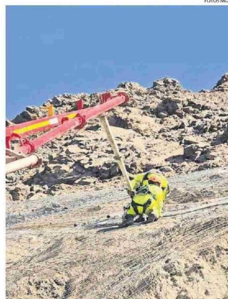
TRABAJOS DE REFORZAMIENTO EN LA LADERA.
