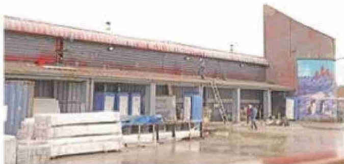
A fuerte ritmo se trabaja en la transformación del local de Avenida Frei, de propiedad de SMU.
