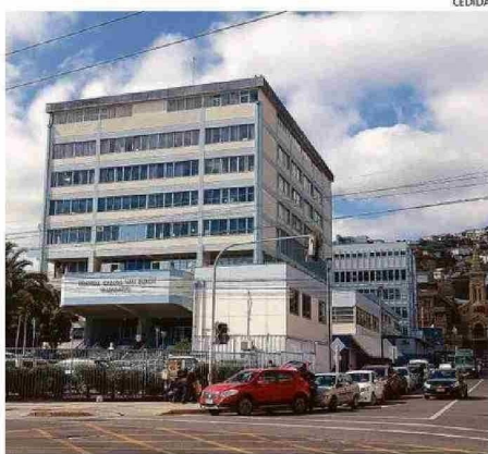
EL RECINTO REQUIERE URGENTEMENTE DE UNA AMPLIACIÓN.
