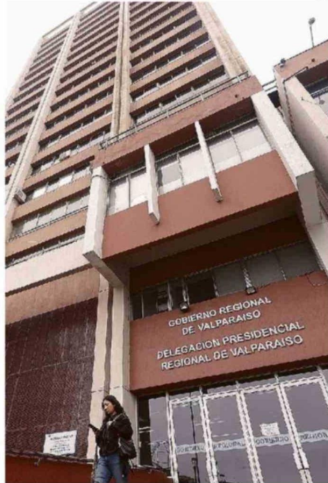
EDIFICIO ESMERALDA HOY ESTÁ PRÁCTICAMENTE DESOCUPADO.
