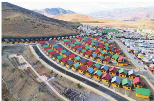
El Plan Habitacional de Emergencia en la región supera en avance al promedio registrado a nivel nacional.
