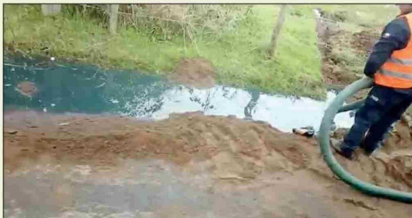
La fuga de hidrocarburo se produjo en el oleoducto de ENAP, en el contexto de una mantención programada.
