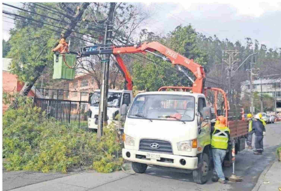
Compañías han trasladado brigadas desde otras regiones para acelerar trabajos de reposición de la luz y de infraestructura dañada.
