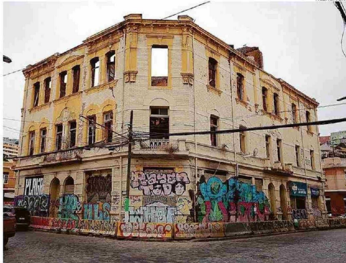
EL DETERIORADO ESTADO DEL BARRIO PUERTO GRAFICA LA PROBLEMÁTICA QUE AFECTA A VALPARAÍSO.
