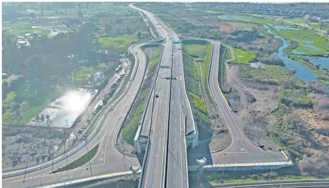
El enlace sur del Puente Industrial contempla una apertura previa a la marcha blanca, habilitando la salida y entrada de vehículos del sector Boca Sur.
