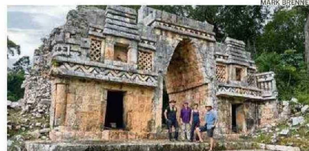
Grandes construcciones se detuvieron durante la escasez hídrica.
