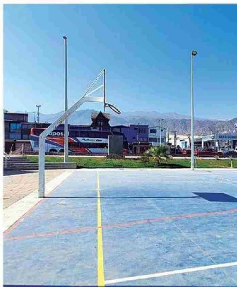
AMBOS AROS DE BASKETBOL PRESENTAN DAÑOS.
