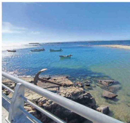
La obra fue comprometida en 2023 tras incendio.
