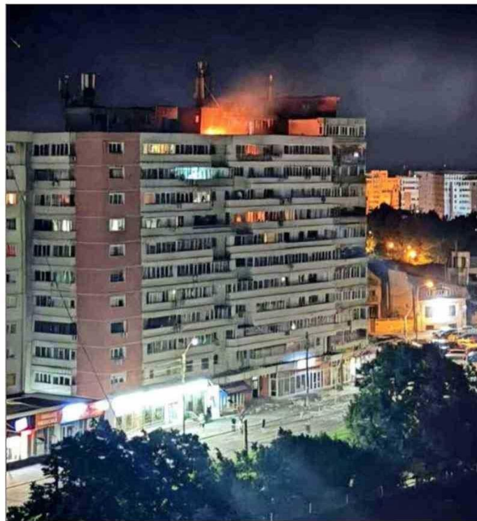
EL IMPACTO del dron provocó un incendio en un edificio residencial en Galati, una ciudad rumana cercana a la frontera con Ucrania.
