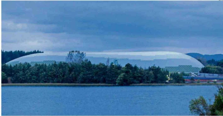
La construcción está en la parte céntrica de la ciudad, donde se une la vida de la urbe con la universitaria y la naturaleza.
