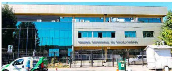
Dependencias donde se mejorará el sistema eléctrico corresponden al Centro de Referencia del antiguo Hospital de Curicó.
