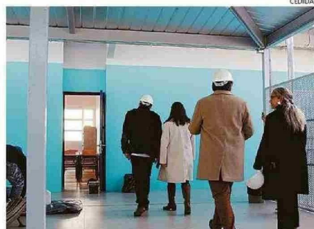
OBRAS DEBERÍAN CONCLUIR COMPLETAMENTE EN OCTUBRE.
