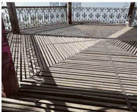
PISO DE LA GLORIETA ESTÁ INESTABLE, CON PIEZAS POCO FIRMES.
