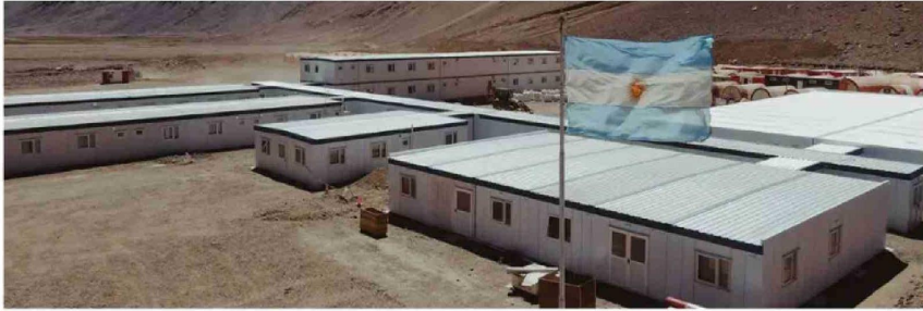
Proyecto Los Azules , en la provincia de San Juan, Argentina. La iniciativa contempla una producción cercana a 140.000 toneladas anuales de cobre hacia 2029 y cuenta con aprobación bajo el régimen RIGI.
