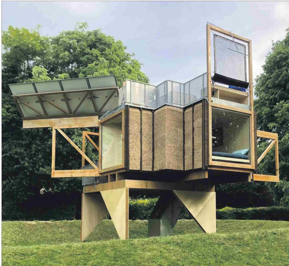
En la casa se distinguen el atrapaniebla y los paneles solares en el techo, el revestimiento danés al medio y los pilotes.
