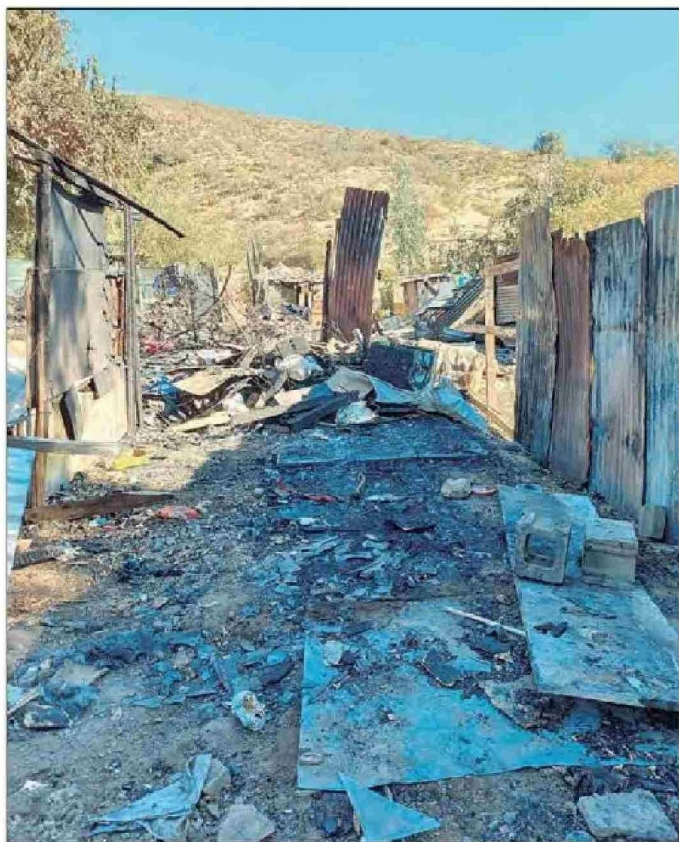
La gráfica da cuenta de los daños que dejó el incendio en "La Toma" de El Polígono.
