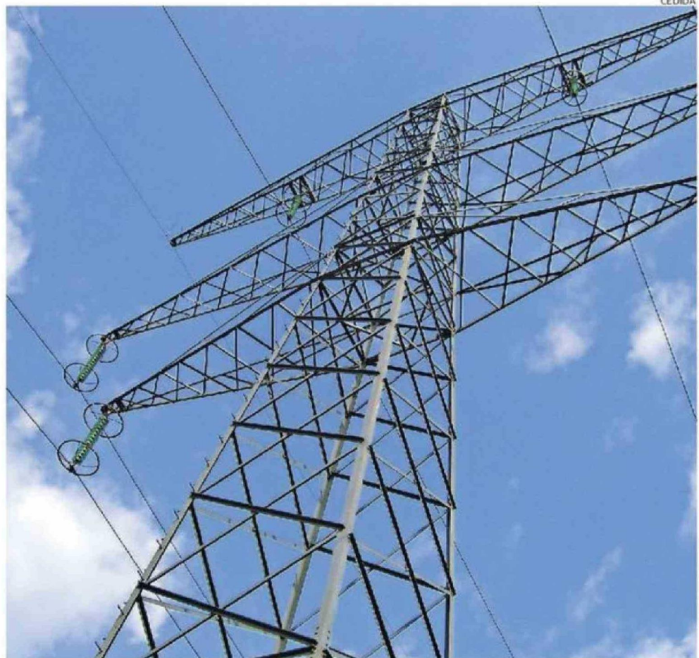
ENTRE LAS OBRAS PERMANENTES SE CONTEMPLAN 409 ESTRUCTURAS PARA LA LÍNEA DE TRANSMISIÓN.
