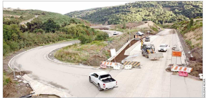
En junio vence el plazo para la tercera empresa que acomete la obra, que ya duplica su valor. Y pese a que se negó a la apertura parcial, por motivos de seguridad, a diario cientos de vehículos usan varios tramos del trazado.
