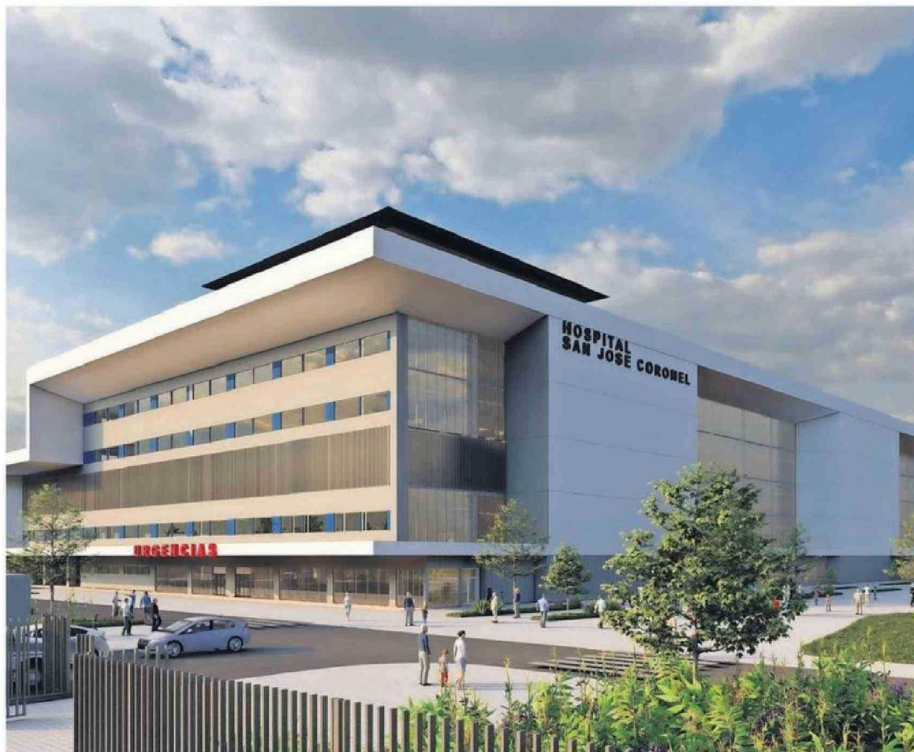
La concesión contempla la construcción y mantenimiento de hospitales en Santa Bárbara, Lota, Coronel y Nacimiento.
