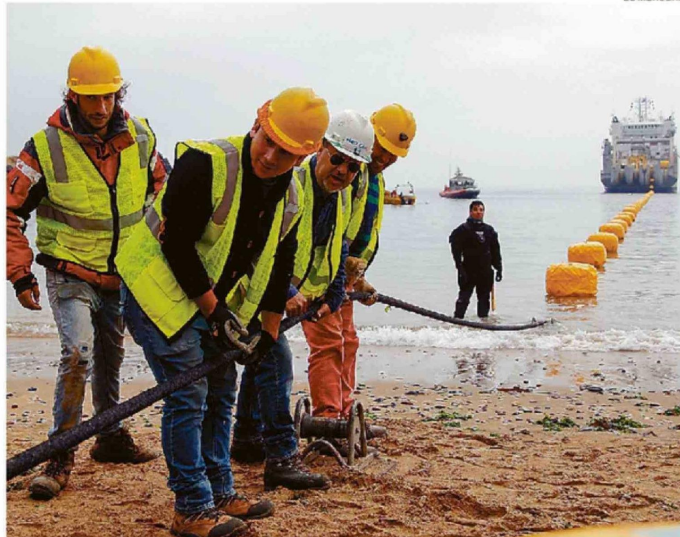
EN ABRIL DE 2019, GOOGLE REALIZÓ TRABAJOS DE INSTALACIÓN DE SU CABLE EN LA PLAYA LAS TORPEDERAS.
