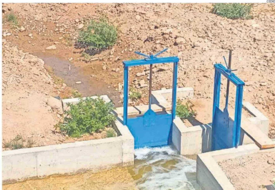
PARTE DE LAS OBRAS INAUGURADAS Y QUE PERMITIRÁN QUE EL RECURSO HÍDRICO SEA MÁS EFICIENTE.
