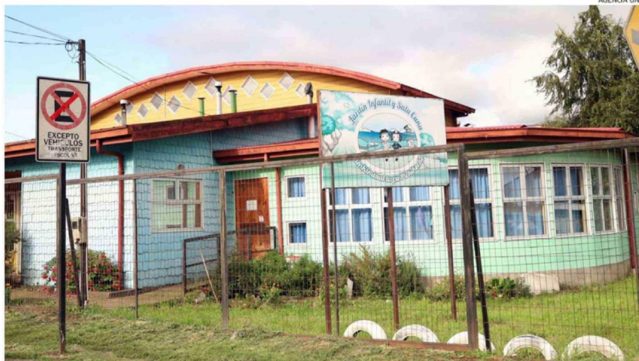
EL RECINTO ES ADMINISTRADO POR EL MUNICIPIO Y ESTÁ EN MEDIO DEL SECTOR QUINTO CENTENARIO. CONSTANTEMENTE ES VULNERADO POR HAMPONES.
