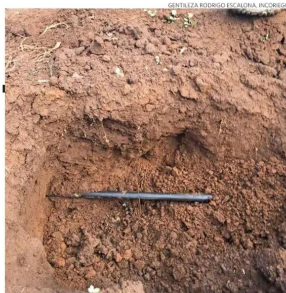
La tubería está enterrada a una profundidad que varía entre 5 y 30 centímetros, según el cultivo.
