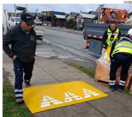
LOS REDUCTORES DE VELOCIDAD YA ESTÁN INSTALADOS.
