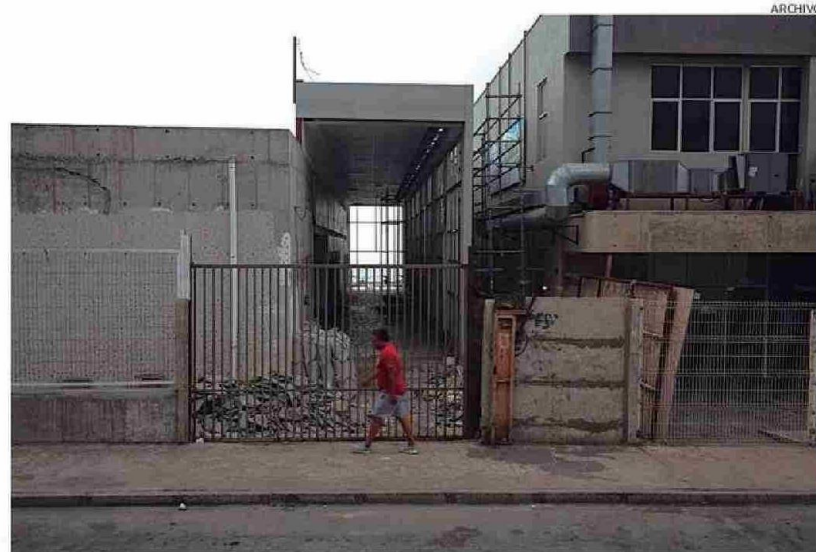
LAS OBRAS DE LA UNIDAD DE MEDICINA NUCLEAR QUEDARON ABANDONADAS EN EL AÑO 2020.
