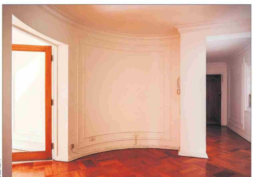
Los departamentos conservan el piso de parqué original.
