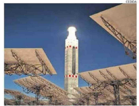
LA CENTRAL SE UBICA EN MARÍA ELENA, A 59 KILÓMETROS DE CALAMA.
