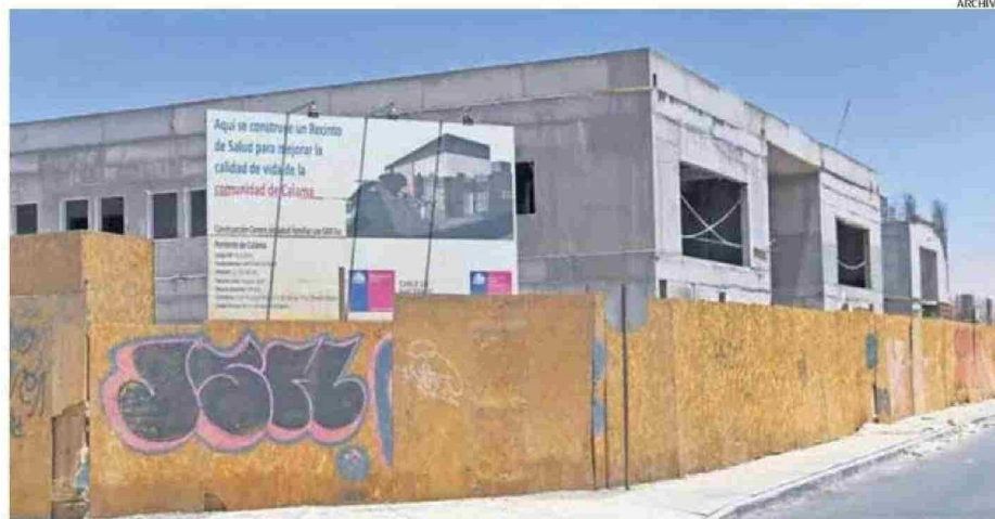
EL CESFAM SUR PONIENTE SIGUE SIN FECHA PARA REINICIAR LAS OBRAS DE CONSTRUCCIÓN EN LA COMUNA DE CALAMA.
