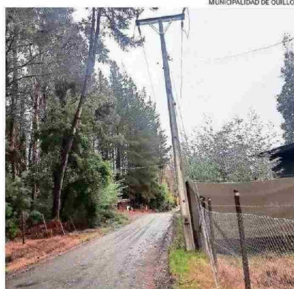
LOS TRABAJOS PREVENTIVOS SON VITALES PARA EVITAR AFECTACIONES.
