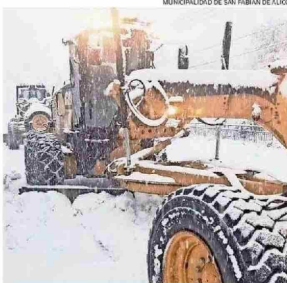
EL DESPEJE DEL CAMINO FUE REALIZADO POR PERSONAL DEL MOP.
