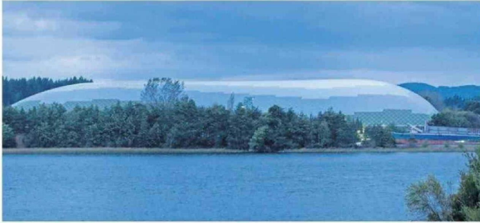
La construcción está en la parte céntrica de la ciudad, donde se une la vida de la urbe con la universitaria y la naturaleza.
