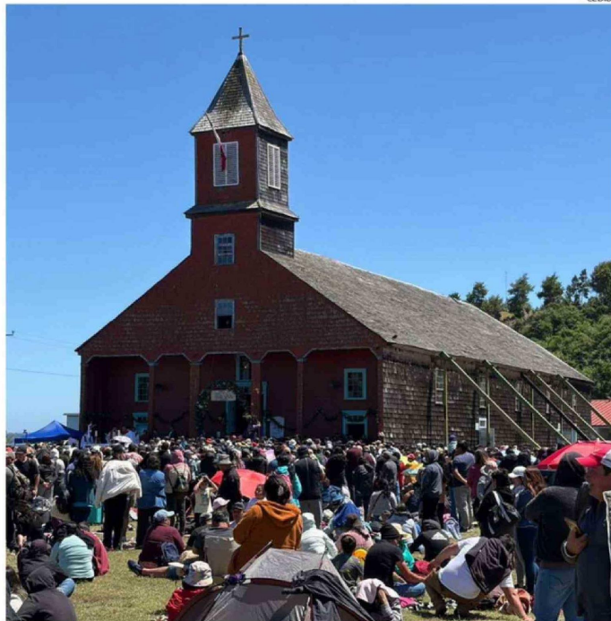
IGLESIA PATRIMONIAL JESÚS NAZARENO DE CAGUACH ESTÁ EN PROCESO DE OBRAS DE EMERGENCIAS
