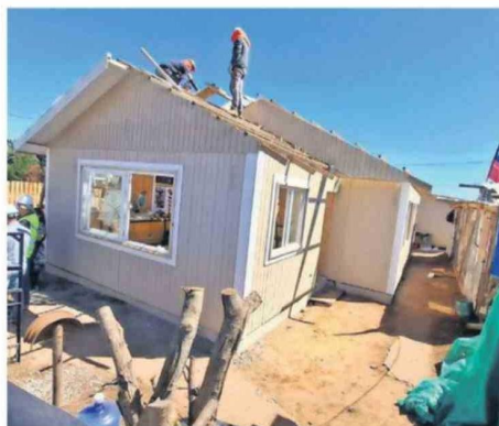
Primeras obras comenzaron en el sector Punta de Parra.
