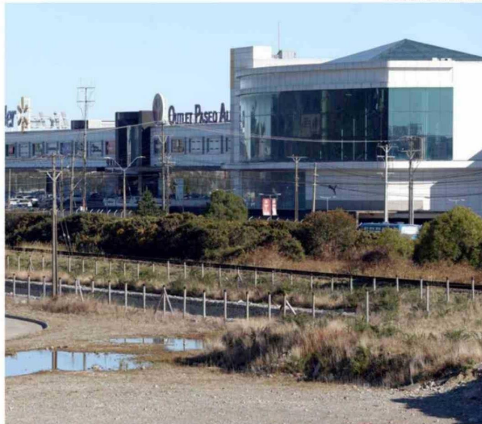
LA ESTRUCTURA DE ENLACE EN ALTURA ESTÁ PROYECTADA FRENTE AL OUTLET ALERCE DEL GRUPO PASMAR.
