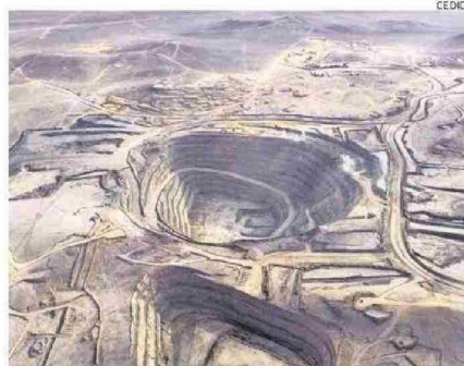
LA OPERACIÓN EXTRAHE MINERALES OXIDADOS Y SULFURADOS DE COBRE.
