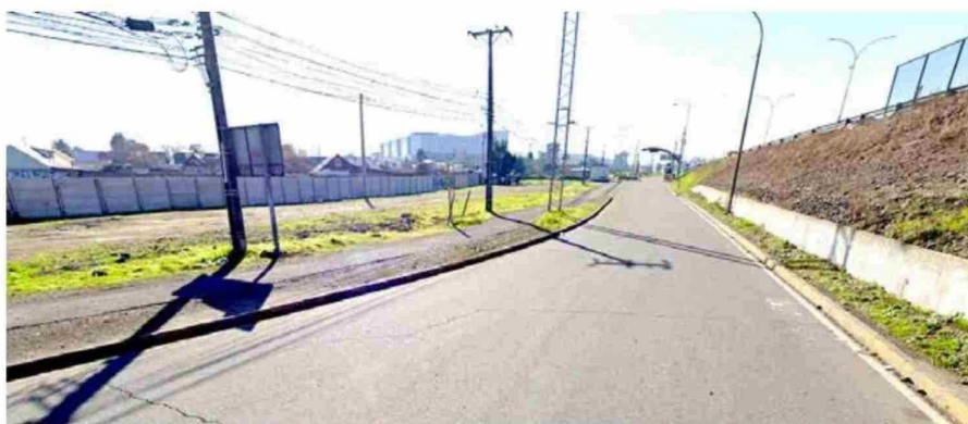
La caletera permitirá descongestionar el tránsito vehicular hacia el nuevo Hospital de Curicó.
