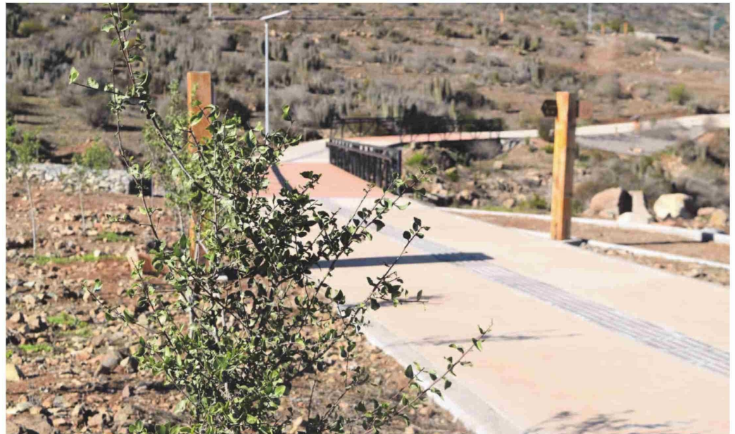
Para fines del año 2024 estaba contemplada la apertura del Parque Cerro Grande. Finalmente, se abrirá en agosto de este año.
