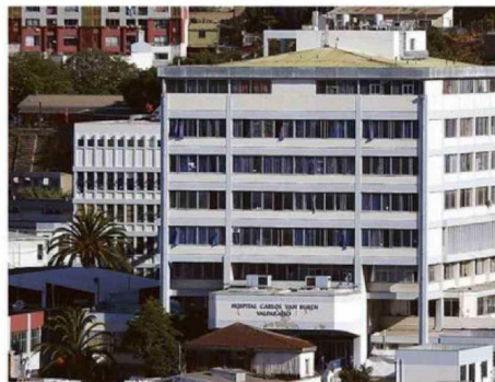
INFRAESTRUCTURA DEL RECINTO ES HOY INSUFICIENTE.
