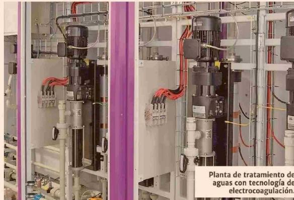
Planta de tratamiento de aguas con tecnología de electrocoagulación.
